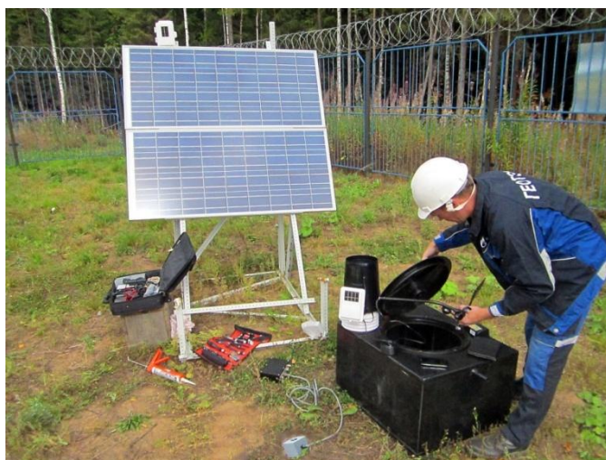
Рис.61. Монтаж оборудования на полтгоне «Березники»
