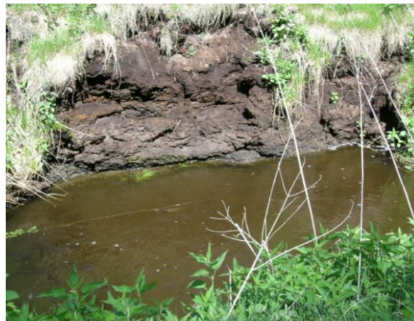
Рис. 10. Эрозия магистрального канала на евтрофном болоте, осушенном 70 лет назад
